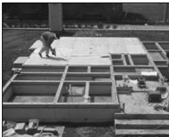
根太レスパネルの施工現場
