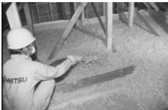
当社のブローイング工事の様子
