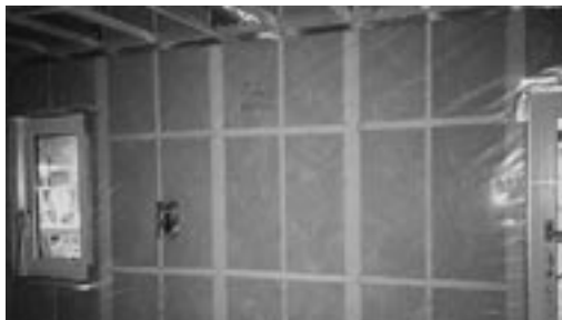
写真1・グラスウールを隙間なく施工した現場
