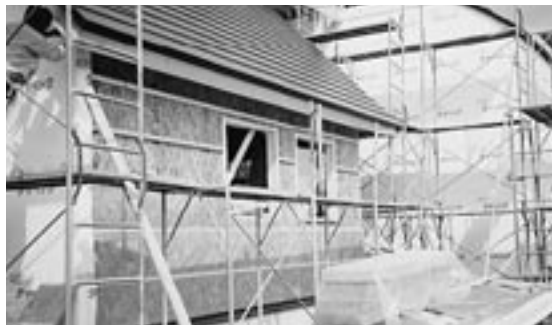
次世代省エネ基準で施工している北海道の住宅。高断熱化によってエネ消費量を抑えながら快適な生活を送れる
