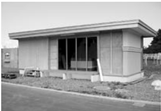
実験棟の外観。様々な断熱工法や外装仕上げ、新しい空間利用などを調査・検証できる設計となっている
