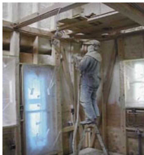
エアライトフォーム S F -100の施工現場
