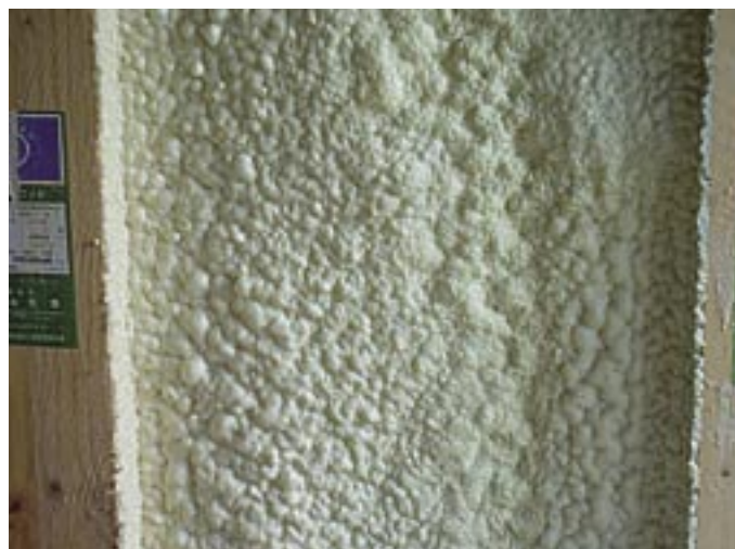
100倍発泡・連通気泡により長期的に躯体に密着し高い気密性を確保する
