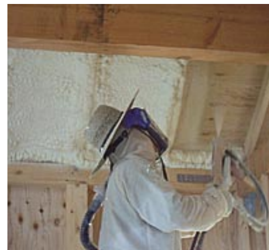
反応が速いため、天井に施工しても垂れることはない
