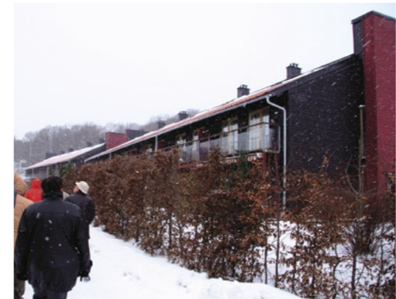
日本にも紹介され大きな関心を集めたスウェーデンの無暖房住宅。外壁断熱厚は420mmと断熱先進国だけあってその取り組みはスケールが大きい
