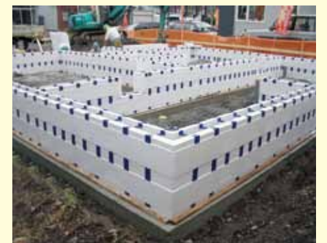
採用実績が累計2,000棟を超えた「かんたんベース」の施工現場。断熱性能や施工性が評価されて新規に採用する現場が増えつつある
