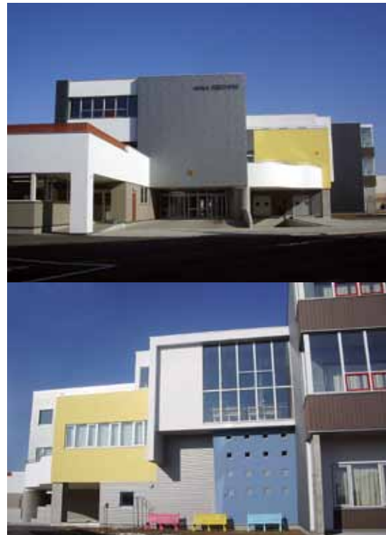
事例2 厚岸町・真龍小学校改築工事（㈱アトリエア設計）
