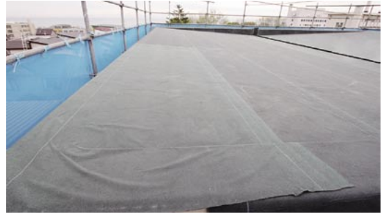
防水性に優れる改質アスファルト系シートを下葺きした北海道の陸屋根（スノーダクト仕様）。このように雨漏りの不安がない仕様として納まり図を提出すれば、1/50 未満の勾配でも保険適用可能かどうか判断してもらえる
