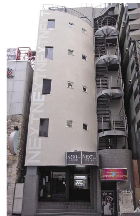
札幌すすきのの歓楽街に建つ「ネクストビル」。湿式 仕上げによるシームレスな外装仕上げが印象的
