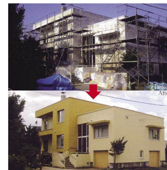
既存の住宅全体を外側から断熱することで、オーナーが住んだまま付加断熱と外装の化粧直しができる（写真は従来製品による施工です）
