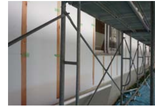
胴縁間にEPS 16mmを施工
