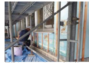
胴縁を455mmピッチで打ち付け
