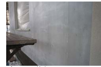
プライマー塗布
