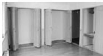
写真2・収納部分は汚染空気が滞留しないように開放しておく
