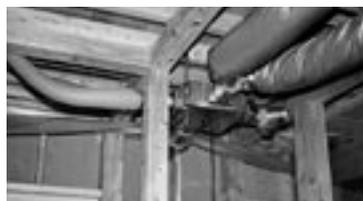
写真1・換気システムは設置後すぐに作動させる
