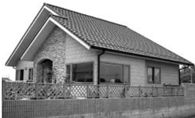
玄関廻りにカルチャードストーンを採用し、意匠的にも独自の個性を演出した同社の高断熱・高気密住宅
