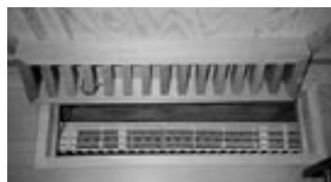
写真2・床下に暖房機を設置した例
