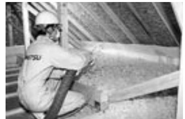
写真1・プローイングであれば比較的簡単に天井の断熱補強ができる
