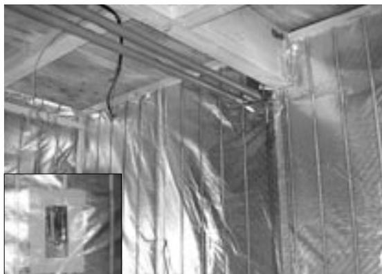
断熱材の性能を十分発揮できるように気密施工もしっかり行われている。コンセント（左下）も気密コンセントボックスと気密テープで処理している
