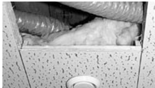
写真1・天井ふところの断熱材も規制対象になる
