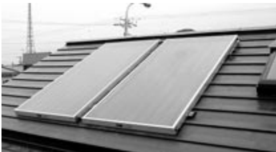
太陽熱給湯システムの集熱パネルを屋根面に設置した住宅
