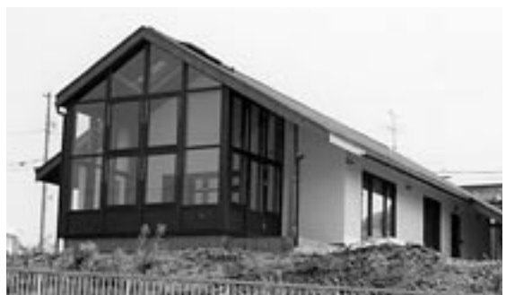
南面にガラス面積の広い木製サンルームを設け、パッシブソーラーシステムとした住宅
