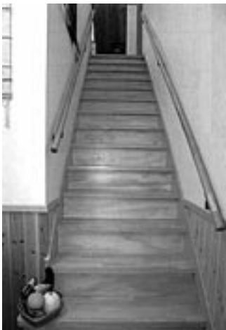
写真1・誰でも昇り降りできるよう両側に手すりを付けた例
