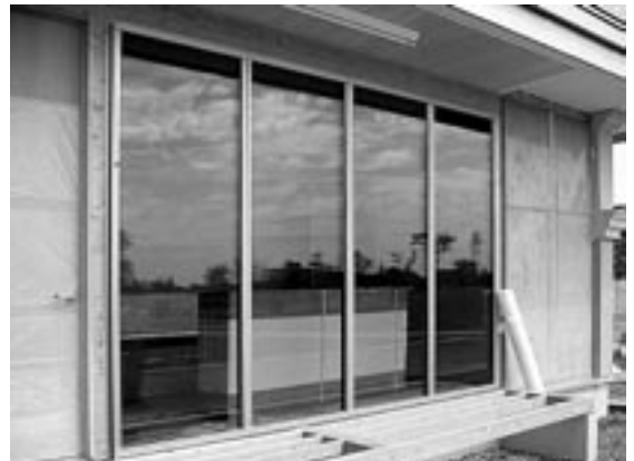
総厚50mmの高断熱・高遮音ガラス。室外側を単板ガラスで覆ったダブルスキンゾーンという空間が作られる予定
