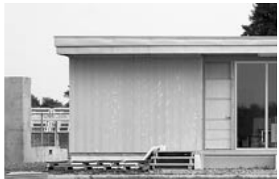
実験棟南側は、向かって左側の外装材に新開発の窯業系サイディングを施工。モノクロではわかりにくいですが、ライトブルーのカラーが特徴的
