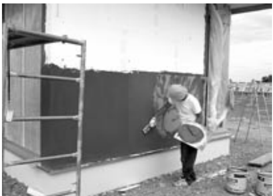
断熱付加と高耐久な外装仕上げを同時に実現するE I F Sを施工した外壁部分(上)。施工も簡単で、左官技術がなくても扱うことができる(下)
