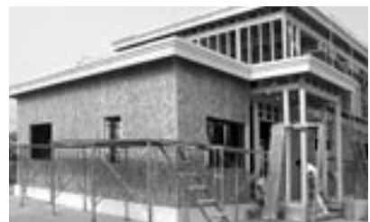
写真2・OSBを壁の面材に使った現場
