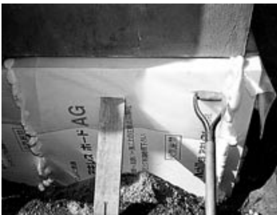
板状断熱材で基礎断熱改修を行っている現場
