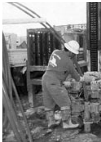
写真C・地中に不凍液を回す採熱管を挿入している現場。地熱式はボーリング費用が大きな課題
