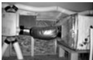
写真B・換気ファン(左)とつながっている排熱回収式ヒートポンプの本体(右)
