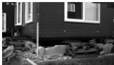
写真2・沢の埋め立て地で液状化現象が起り、補修工事を行っている住宅
