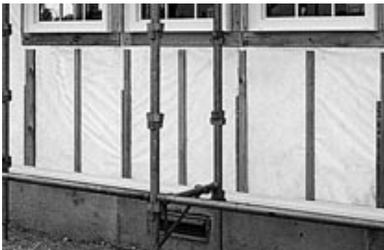
通気胴縁の施工写真。窓下は空気が左右に逃げるように少し空けている
