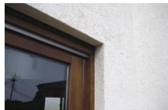
窓回りの納まり。100mmのEPSを使っているのので、その分、壁面がサッシより屋外側に出ている
