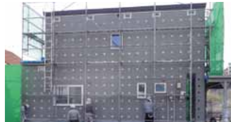
通気層を塞ぐため、既存サイディングに壁体内に入った湿気を排出する穴を45mmピッチで空けた
