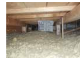
天井はブローイングを増し吹きし、断熱厚400mmとした
