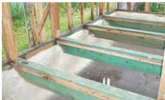
断熱補強と土台・基礎天端間の気密化を兼ねて、布基礎内側に現場発泡ウレタンを施工している現場もある
