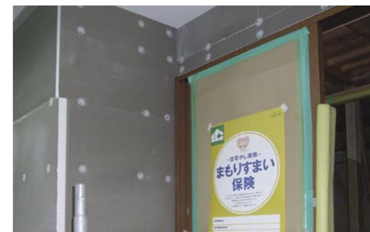
外張り付加断熱材として施工された『DAN壁』
