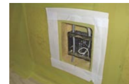
コンセントも気密化専用部材を使用
