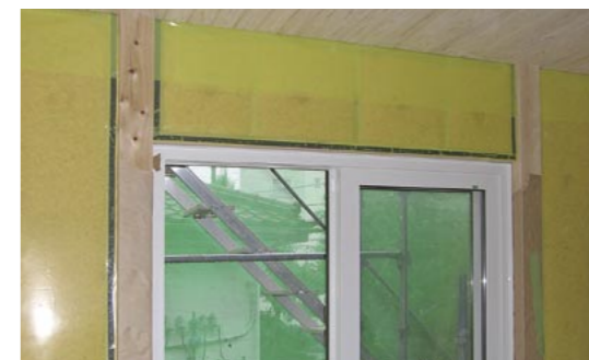
防湿・気密シートで丁寧かつ確実に気密化されている
