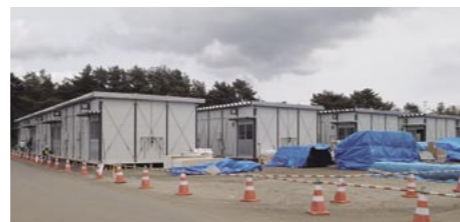
仮設住宅の資材も供給量が追いつかないという
