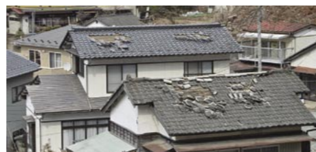
津波を免れた住宅も屋根瓦が破損していることがある。いつ修復できるのか、見通しは全く立たない
