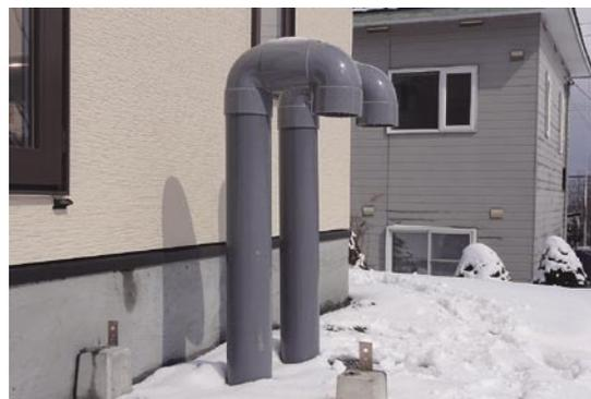
アースチューブの外気導入口。冬はここから外気を導入し、地中で暖めてから室内に供給する
