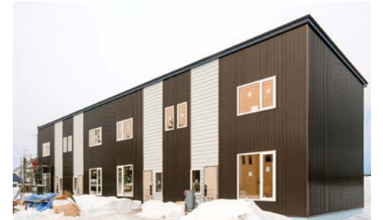
外壁断熱厚が200mmという高断熱賃貸住宅の施工現場。省CO 2 型賃貸住宅への補助によって、このような物件の増加が期待される
