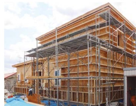
長期優良住宅化リフォーム推進事業に採択された住宅のリフォーム現場。リフォーム・中古流通は国の住宅政策の大きな柱となっている
