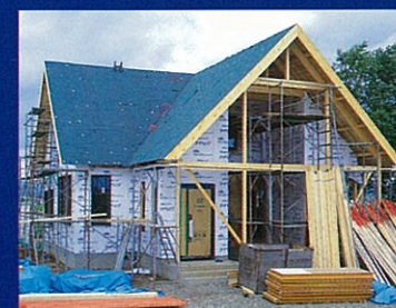
防風シートを貼り外壁仕上げに施工に入ります
