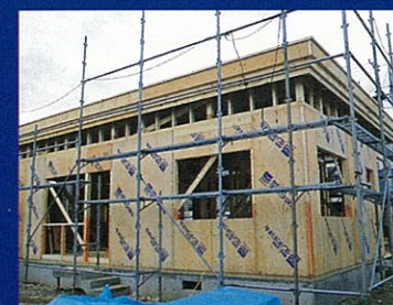
壁パネルの施工が終了した状況
